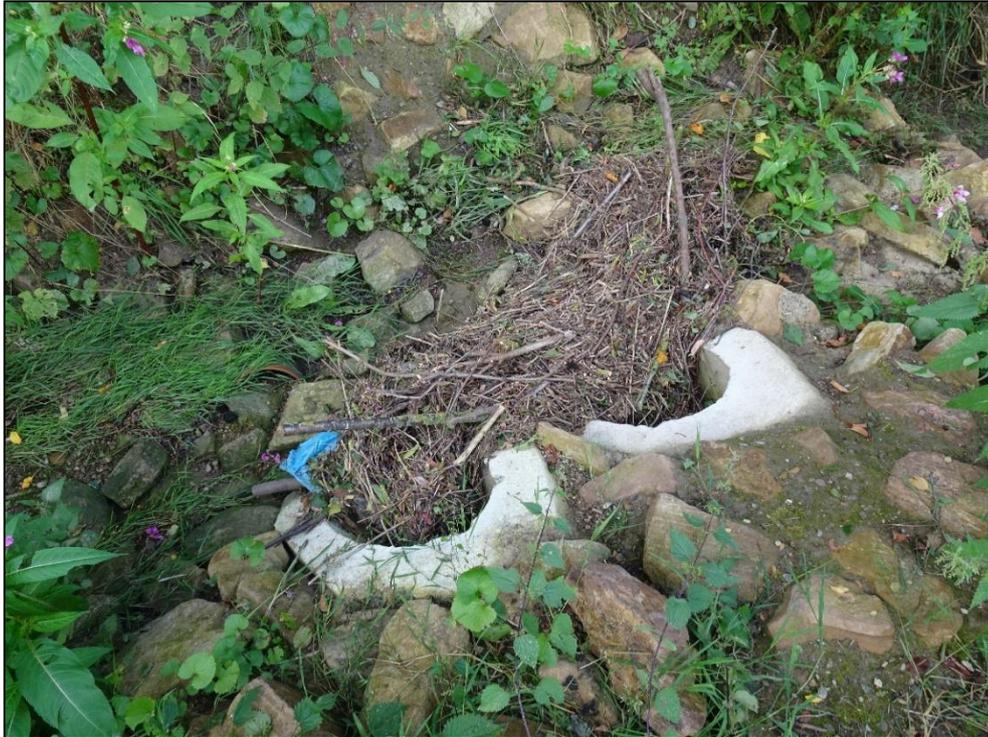
Foto 6: Um die Rohrdurchlässe zur Suderwiese vor Getreibsel aus der Krümme zu schützen, wäre ein Gitterrost hilfreich. (12.08.2021)
