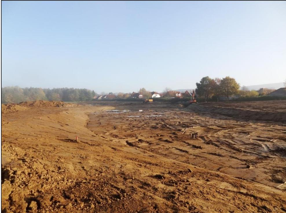
Foto 1: Die Suderwiese während der Bauarbeiten zur Umgestaltung, hier das Ausschachten der südlichen Flutmulde (05.11.2020)
