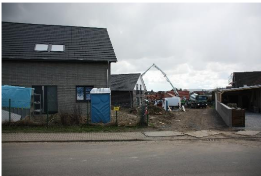
Foto 3: Blickrichtung Süden auf die Bestandsbebauung
