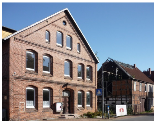
Foto 2: Gebäude Lange Straße 56 (Vordergrund) mit FH ca. 12 m
