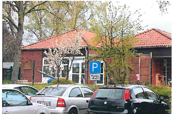
Foto 4: vorhandenes Kindergartengebäude im westli- chen Bereich des Geltungsbereichs
