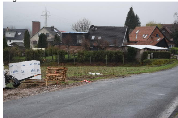
südlich angrenzende Bebauung
