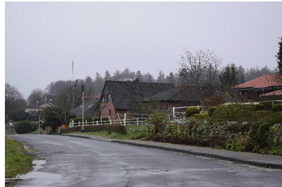
angrenzende Gebäude mit schwarzen Dächern
